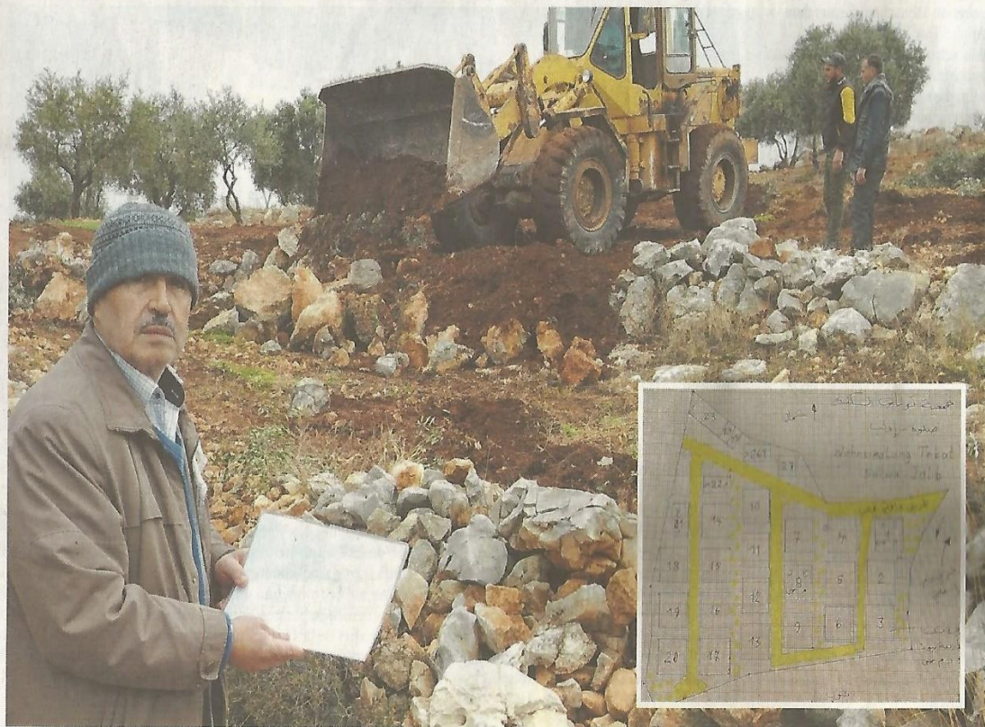
Adnan Wahhoud auf jenem Grundstück im Norden Syriens, das bald ein neues Zuhause für bis zu 80 Flüchtlingsfamilien sein soll. Der Lindauer lässt dort bereits gekieste Wege anlegen, danach will er Fundamente setzen lassen für die künftigen kleinen Häuser.
